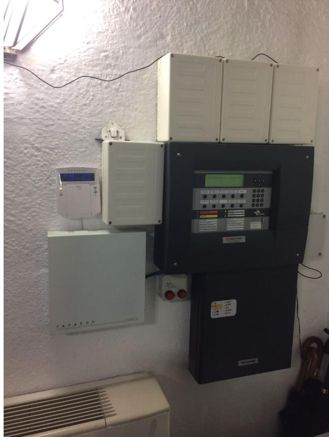
Vista de la central de incendios existente (digital), inadecuada a la red de detección existente que es analógica. (Conserjería)
