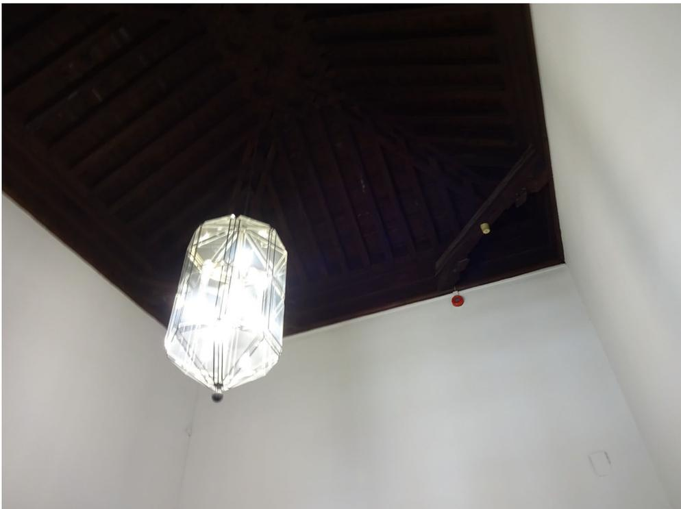
Vista de detector de incendios mal instalado y Sirena obsoleta
