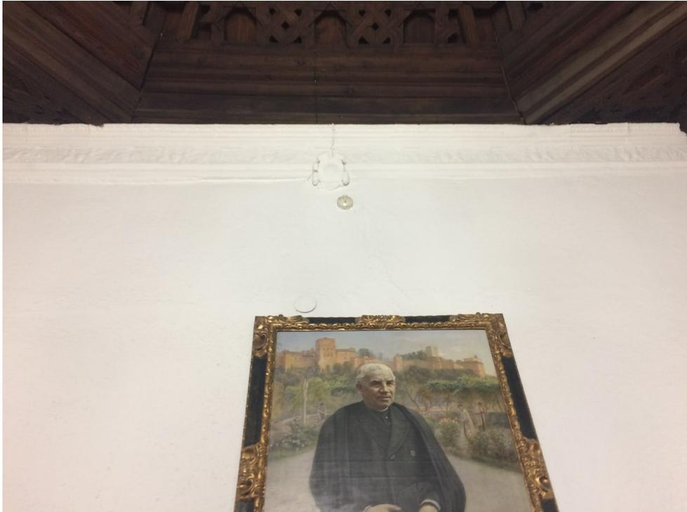
Vista de detector de incendios mal instalado
